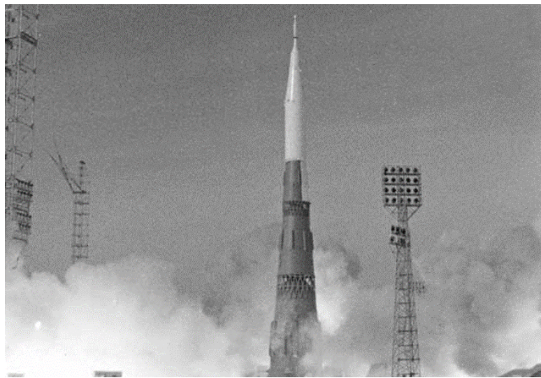
Система Н1-Л3 установлена вертикально на пусковом устройстве. Транспортно-установочное устройство не отведено
